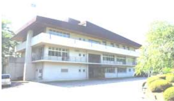
教養センター本館
